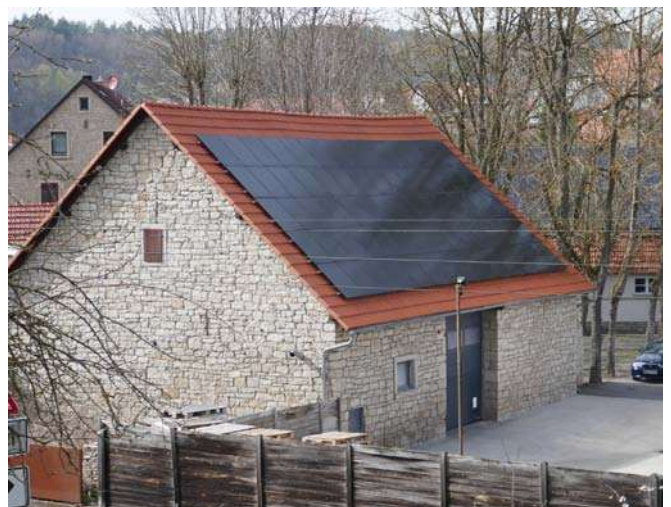
Modulfeld auf einer Scheune
